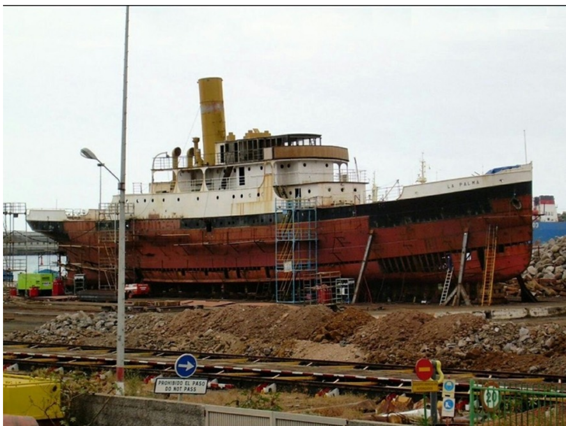
Fig.2. Trabajos de restauración sobre el casco
