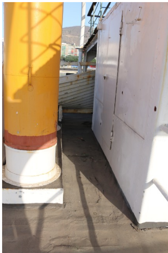
Toma fotográfica nº 6 Pasillo transversal desde estribor.
