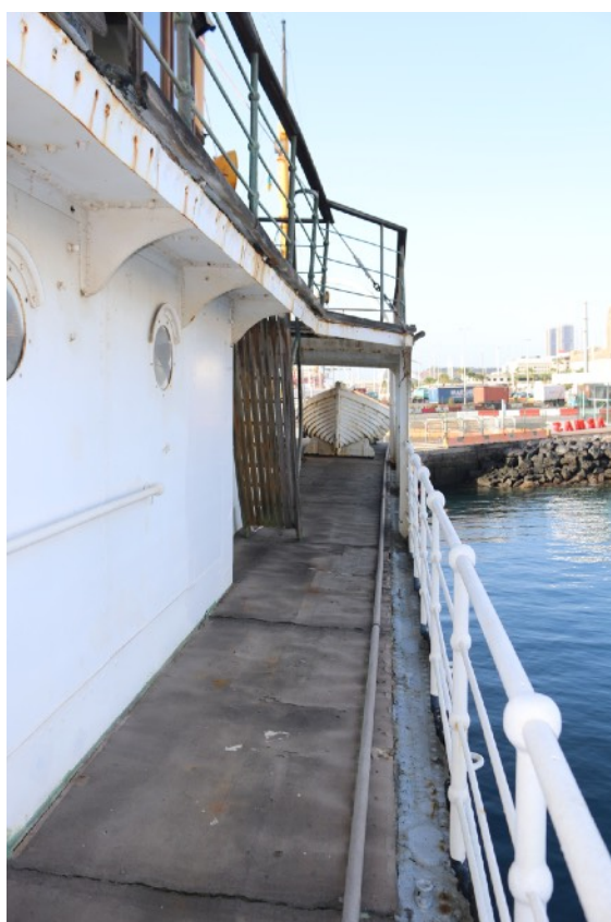
Toma fotográfica nº 12. Pasillo babor de proa a popa.
