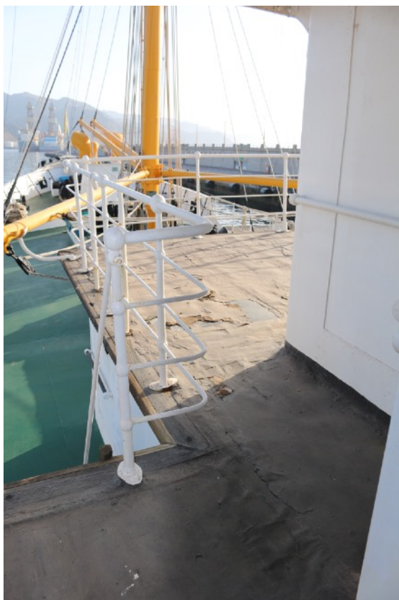
Toma fotográfica nº 11. Tramo final Pasillo babor de popa a proa.
