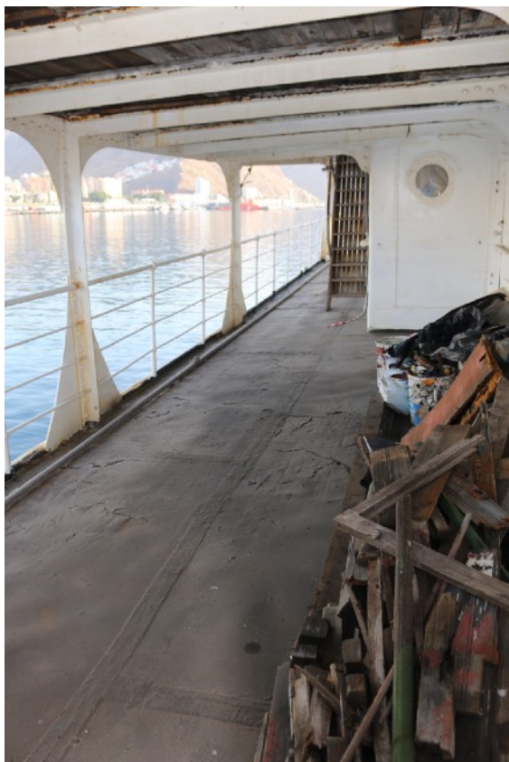
Toma fotográfica nº 9. Inicio Pasillo babor de popa a proa.
