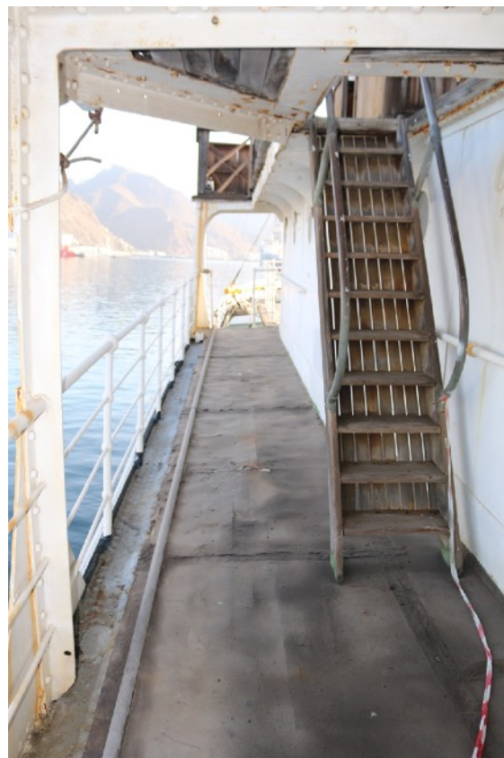
Toma fotográfica nº 10. Tramo medio Pasillo babor de popa a proa.
