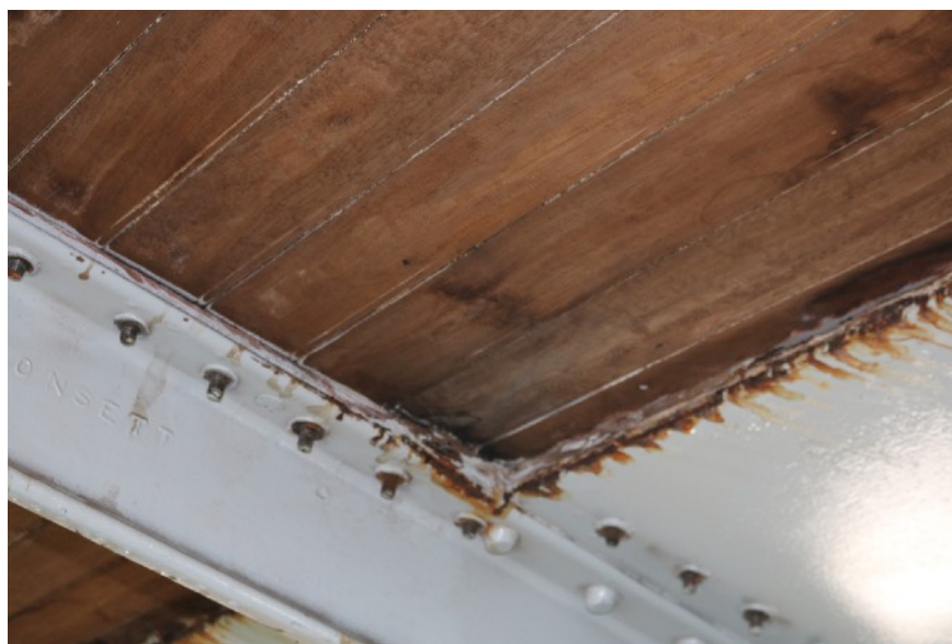
Toma fotográfica nº 14. Detalle del Pasillo estribor de popa a proa.
