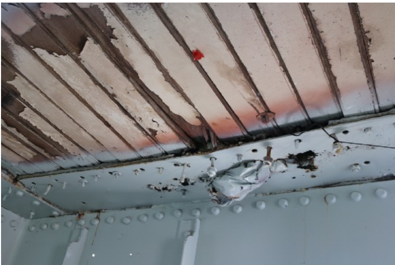
Toma fotográfica nº 16. Detalle del mirador de proa cubierta de botes. Estribor
