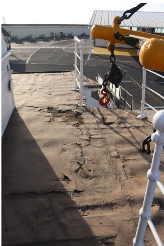
Toma fotográfica nº 7 Pasillo transversal desde babor.
