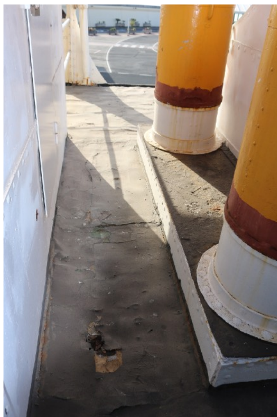
Toma fotográfica nº 8. Pasillo trasversal desde babor.
