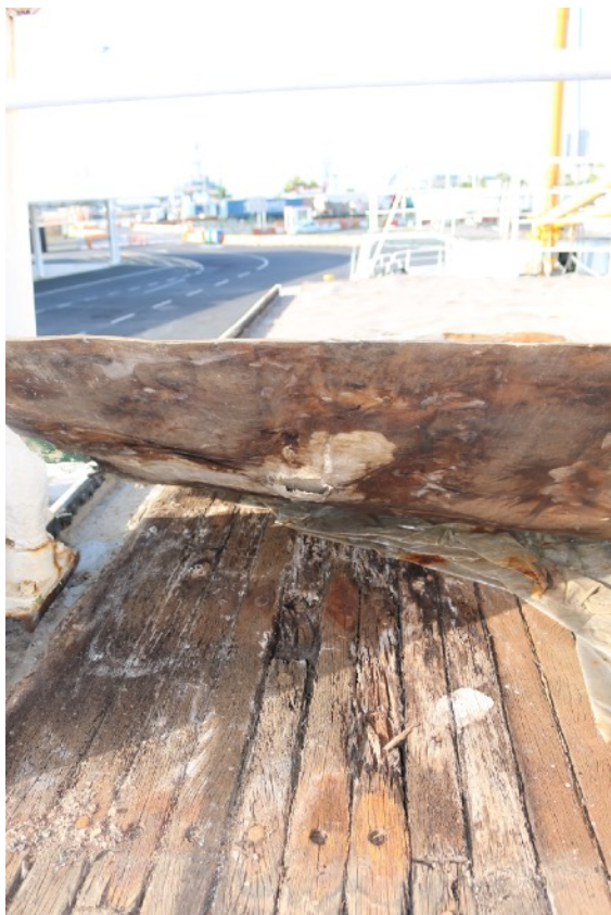
Toma fotográfica nº 5. Final pasillo estribor. ( Bajo lona de protección )
