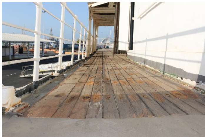
Toma fotográfica nº1. Pasillo estribor de proa a popa popa.
