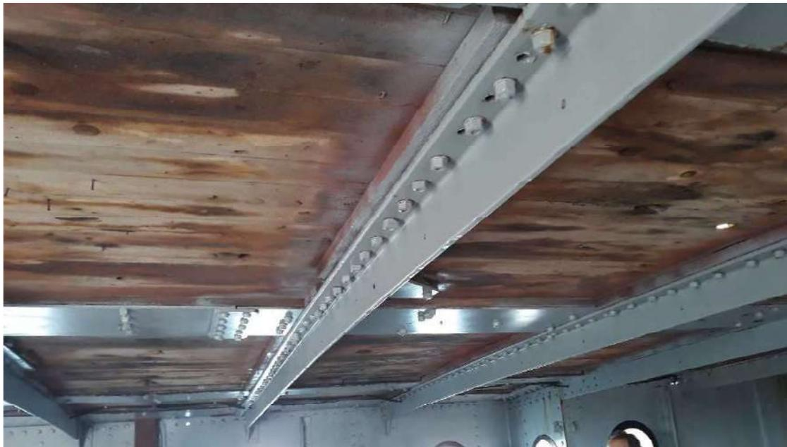
VISTA DE LA CUBIERTA DE PUENTE DESDE EL SU PARTE BAJA.. LAS ZONAS CON MADERA DEBERAN SER CUBIERTAS POR NUEVA CHAPA DE 6 mm.
