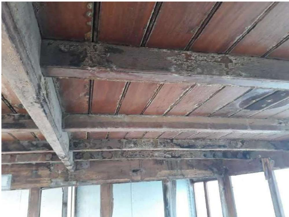
TECHO Y CUBIERTA DEL PUENTE DE NAVEGACIÓN A REMOVER TODAA LA MADERA
